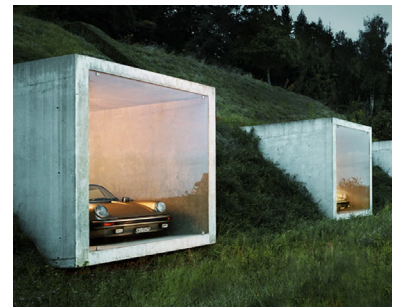
Garagenatelier in Herdern Peter Kunz Architekten
